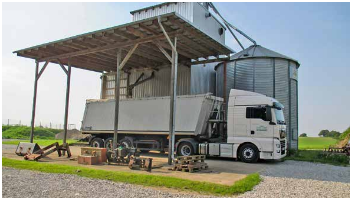
Ein zeitgemäßes Getreidelager und die Güllelagune im Hintergrund schaffen auf Gut Müssen eine gute Infrastruktur für den Bioackerbau.
